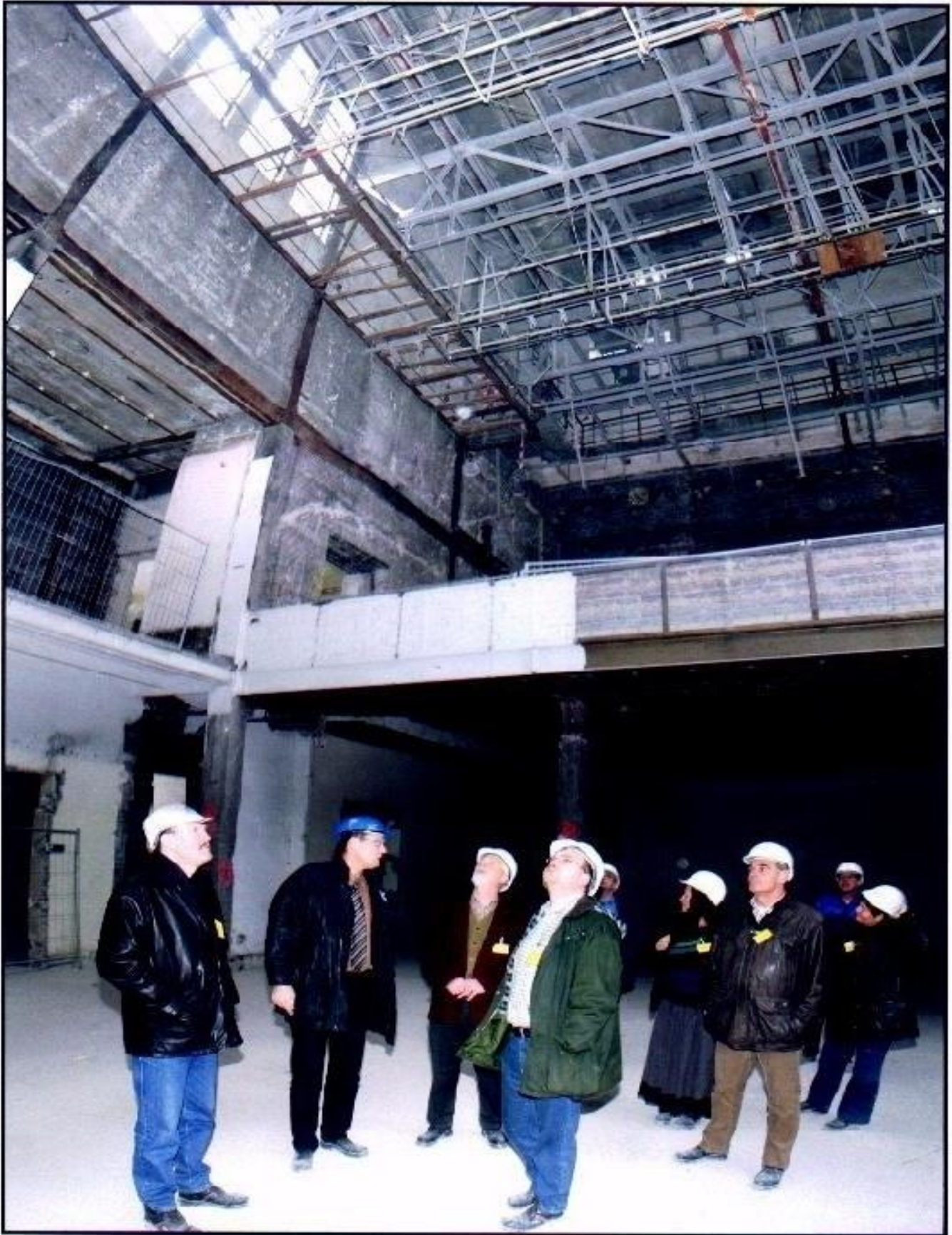
Umbau HSH – Nov. 2003
