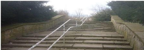
Parkzugang von der Rotthauer Straße
