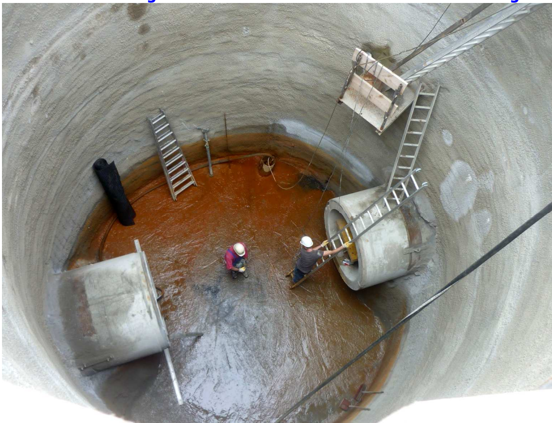
15 Meter geht's hinab auf den Boden des Vorfluters ...
