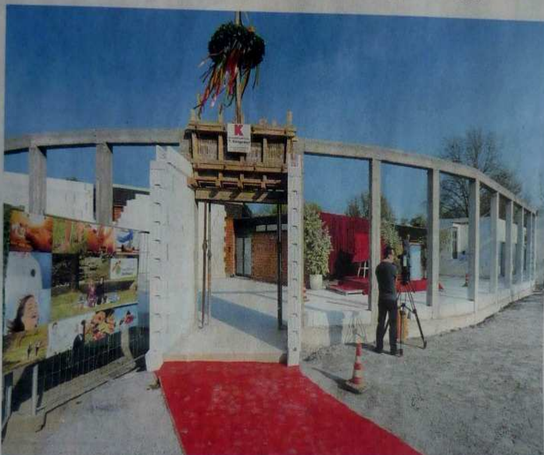
Richtfest am neuen Haupteingang des Gesundheitsparks Nienhausen. Damit ist der alte Revierpark Geschichte.
